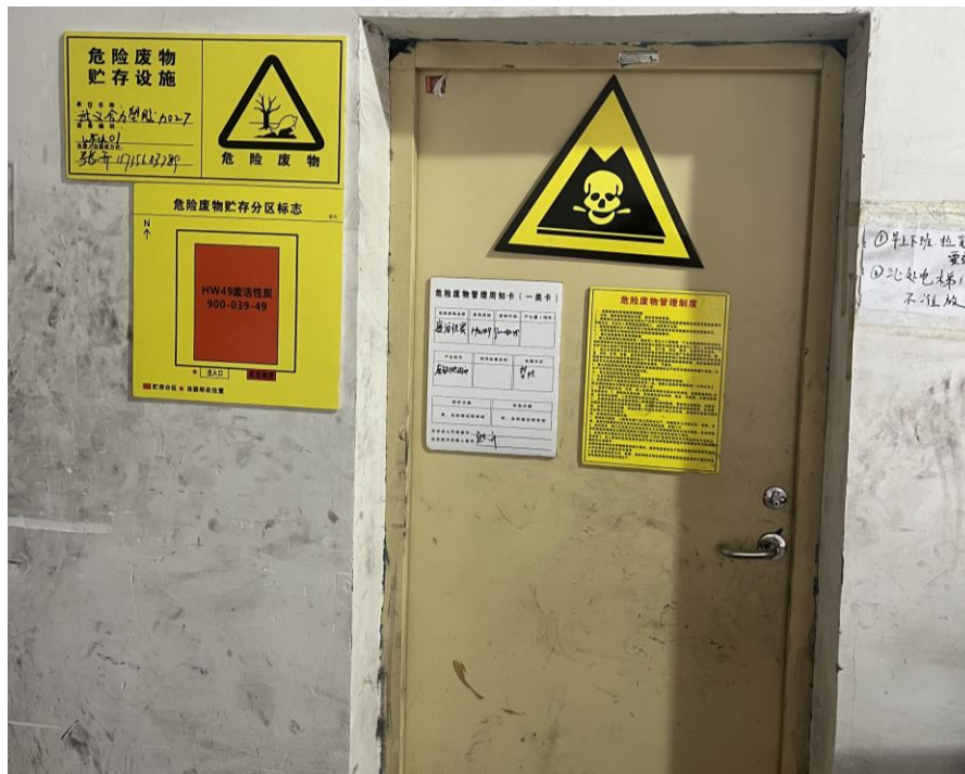
图 3-8 危废仓库现场照片
