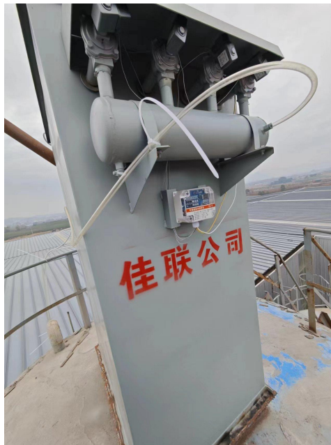
图 3-3 废气处理现场图
