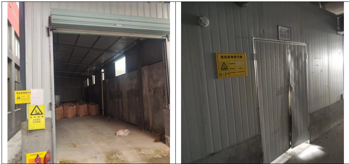
图 3-12 危废仓库现场图
